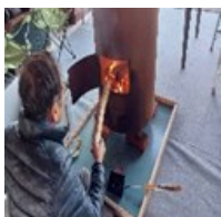
薪ストーブ設置
